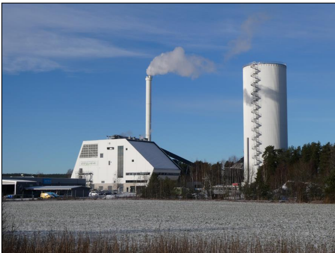
Kraftvärmeverket hos Vimmerby Energi & Miljö AB Foto: Marika Andersson
