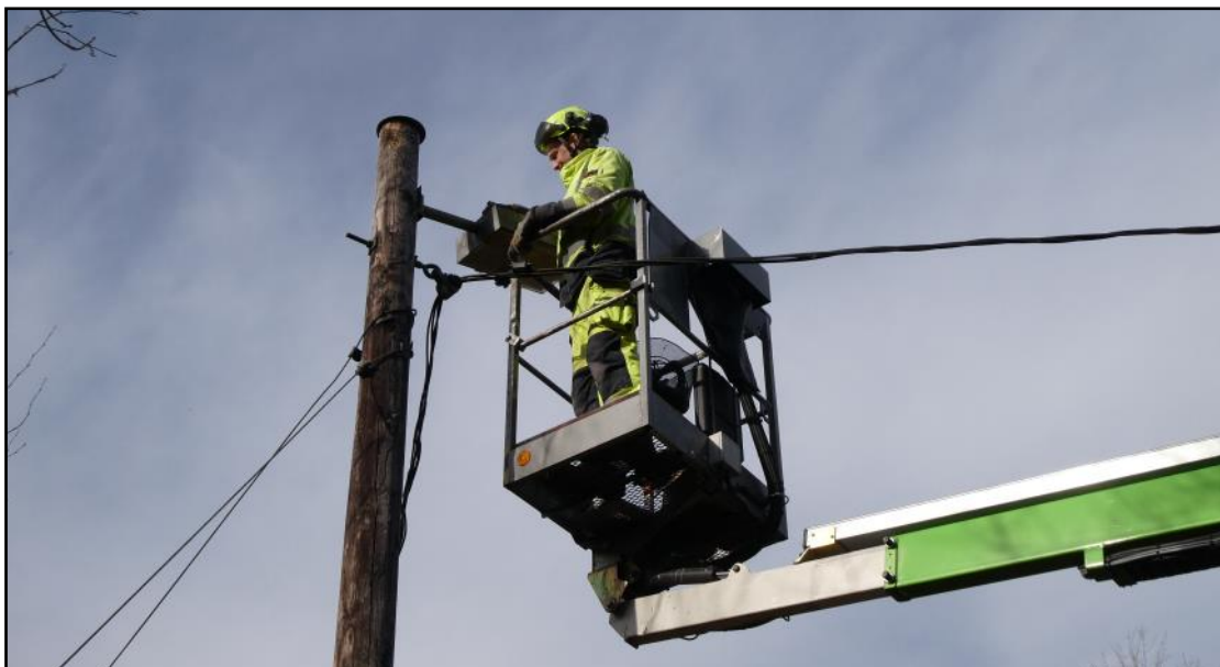
Pontus på på Vimmerby Energi & Miljö AB byter ledarmaturer på elljusspåret i VOK-skogen Foto: Marika Andersson
