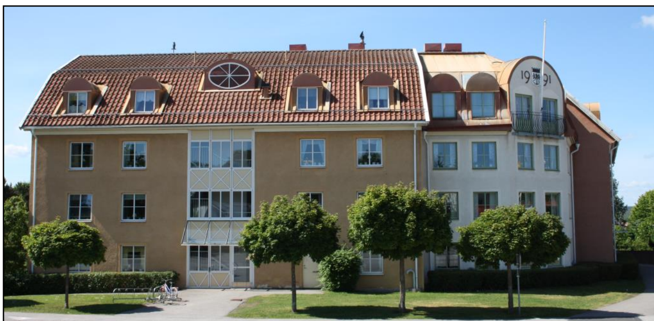
Vimarhems hyresfastighet Lönnen
