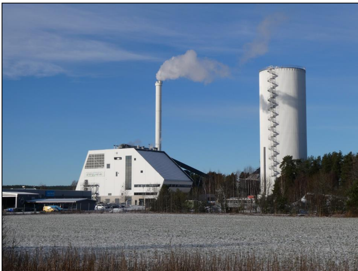
Kraftvärmeverket Tallholmen Foto: Marika Andersson
