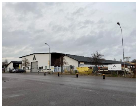
Huvudbyggnad inom fastigheten Maskinisten 14.
