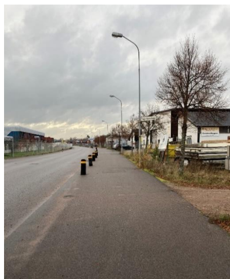
Trafikseparering vid Södra industrigatan.
