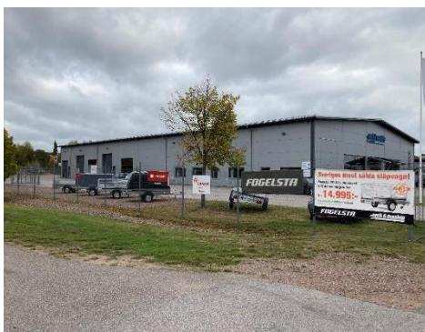
Huvudbyggnad inom fastigheten Maskinisten 13.
