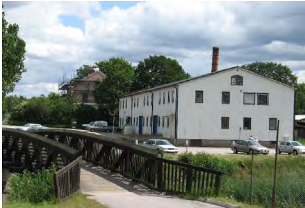
Axel Ståhls möbelfabrik, Åbro
