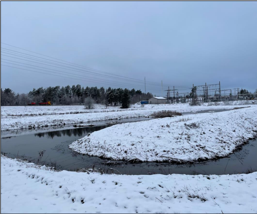
Figur 20: Dagvattendammarna vid korsningen Vimmerbyallen/Riksväg 34/23 under dagvattenvandringen (6 december 2022, Sweco).
