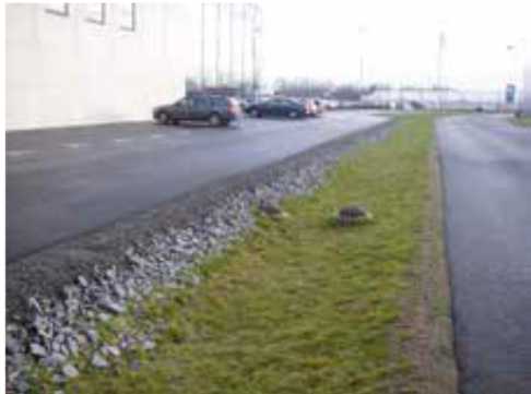
Fördröjning av dagvatten från P-yta
