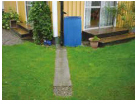
Utledning av takvatten på gräsmatta
